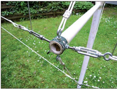
Bild 5: Ein seitlicher Abspannpunkt; die Verwendung einer Schelle ist unbedingt notwendig, um das Ausreißen des Materials zu vermeiden. Sie wird vor Anbringen der Bohrungen auf das GFK-Rohr geklebt. Durch dieses gehen Gewindestangen hindurch, die nur an der Stahlschelle befestigt sind.
