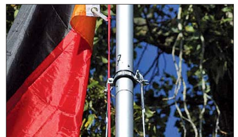
Bild 3: Etwas unterhalb der Spitze befindet sich die obere Befestigung der Wanten.
