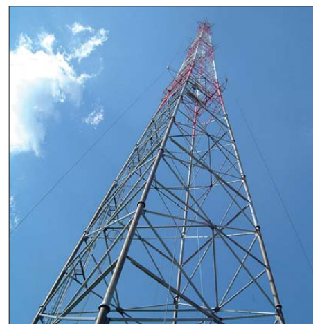
Oberer Teil der 125 m hohen Mittelwellenantenne Sottens Quelle: www.giangrandi.ch
