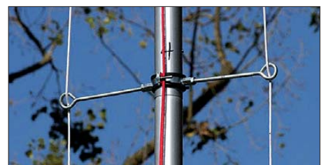
Bild 4: Selbst hergestellte Salinge und ihre Befestigung; die rote Leine dient dem Hissen der Flagge. Die Wanten sind aus einem 8 mm texturilumspunnenen Kunststoffseil.
