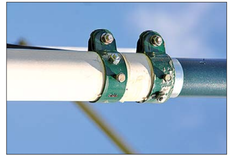
Bild 8: Die Mastbefestigung für ein 40-mm-Aluminiumrohr besteht aus zwei im Abstand von 50 mm auf das Kunststoffrohr geklebten Schellen von 50 mm Durchmesser sowie zwei Schrauben M6. Die M5-Schrauben dienen nur zur Fixierung der beiden Rohre zueinander. Sie drücken ebenfalls nicht direkt auf das GFK-Rohr, sondern auf die flächige Stahlblechbeilage.
