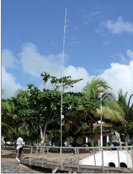
Die Vertikalantenne für 80 m und 40 m
