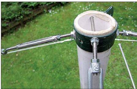
Bild 6: Der untere Abspannpunkt; gut zu sehen sind die modifizierten Seilspanner. Die Gewindestangen M5 sind im Winkel der Abspannung gebogen.
